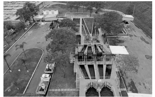
Estação de tratamento de esgoto Onça, da Copasa, em Belo Horizonte. 2.jun.25/Divulgação Copasa
